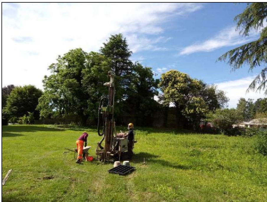
Foto n. 4.14 – Postazione sondaggio S12 profondo c.ca m 3,00 da p.c..
