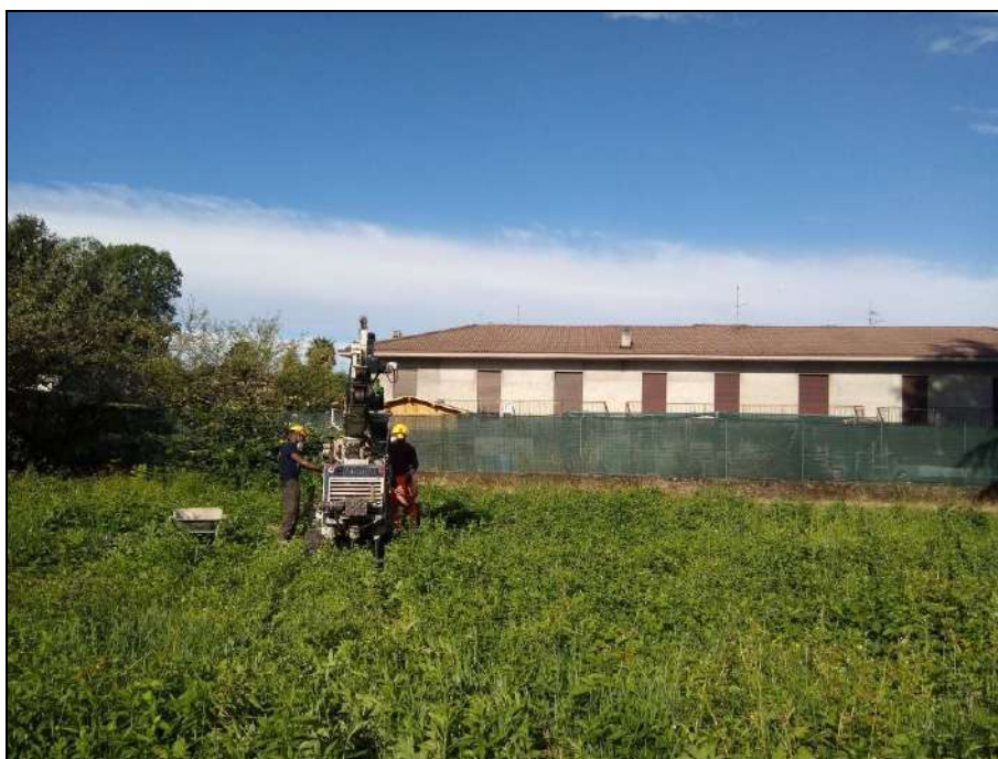
Foto n. 4.13 – Postazione sondaggio S11 profondo c.ca m 3,00 da p.c..
