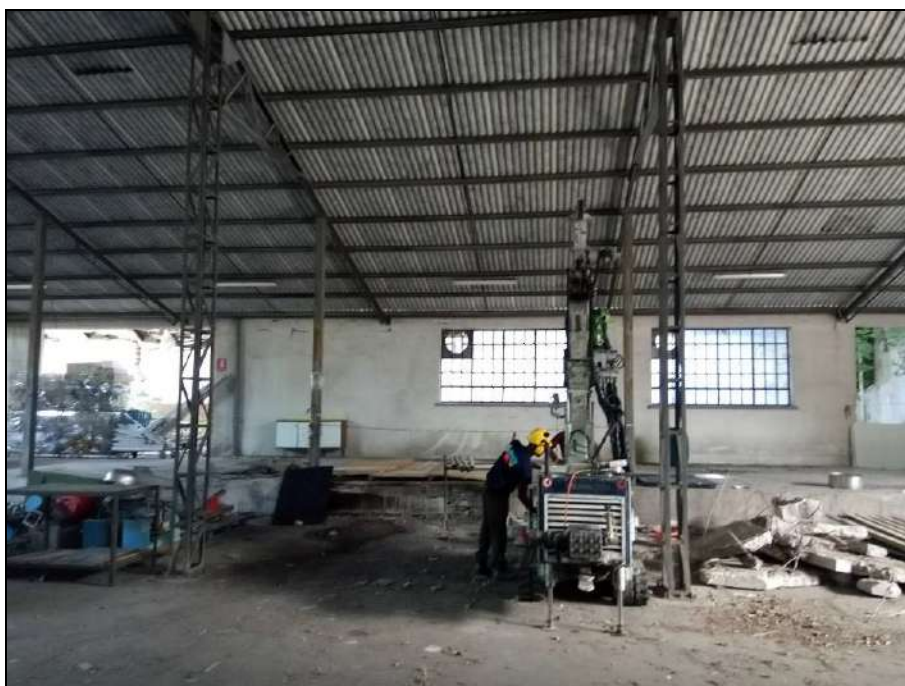
Foto n. 4.5 – Postazione sondaggio S3 profondo c.ca m 7,0 (m 6,6*) da p.c. (inclinato di 20° verso la vasca).
