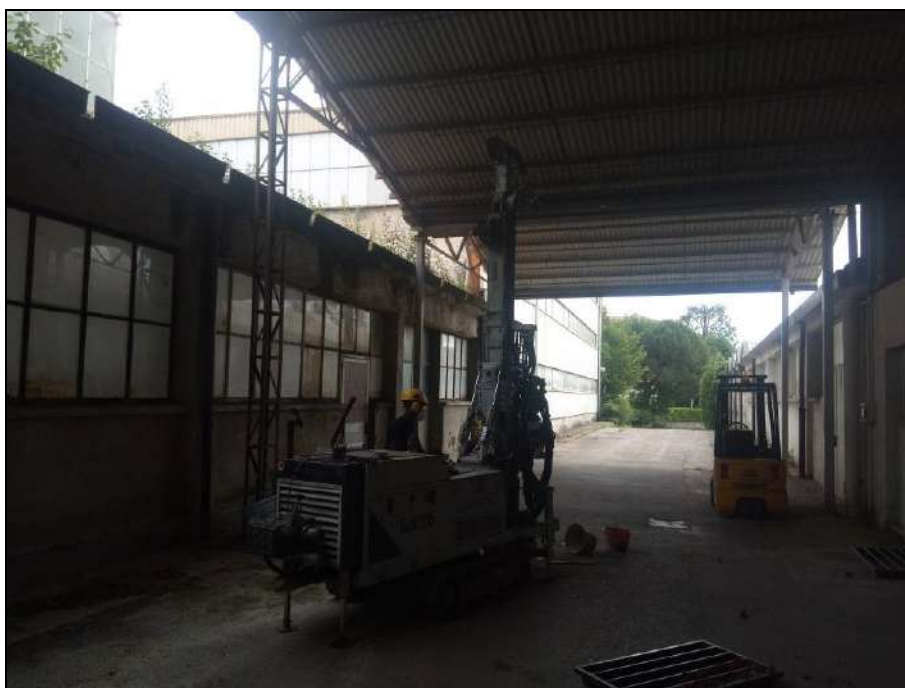
Foto n. 4.8 – Postazione sondaggio S6 profondo c.ca m 3,00 da p.c..
