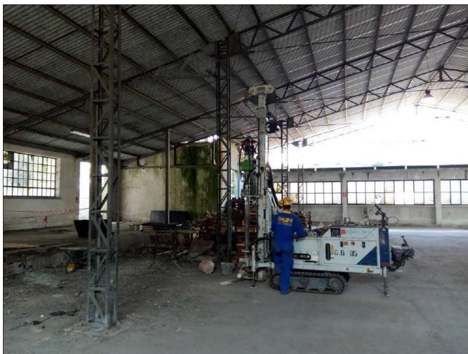
Foto n. 7.4 – Postazione sondaggio S17 profondo c.ca m 10,00 da p.c..
