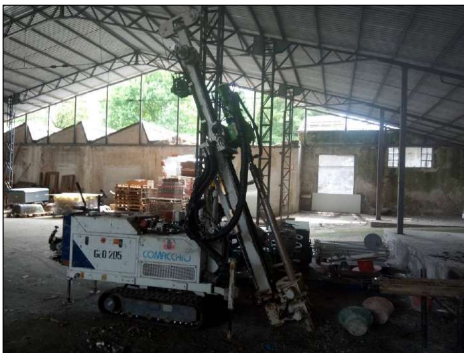
Foto n. 4.4 – Postazione sondaggio S2 profondo c.ca m 7,0 (m 6,6*) da p.c. (inclinato di 20° verso la vasca).
