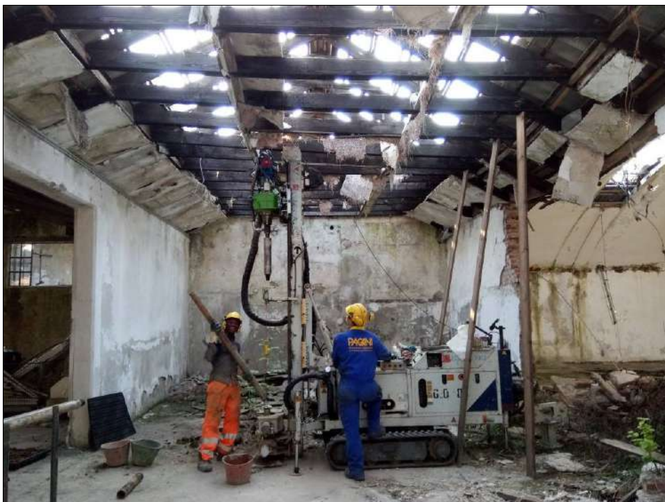
Foto n. 7.3 – Postazione sondaggio S16 profondo c.ca m 10,0 da piano tetto della vasca olio combustibile.
