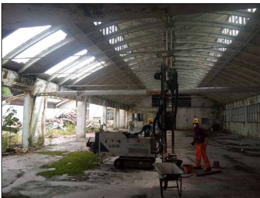
Foto n. 4.9 – Postazione sondaggio S7 profondo c.ca m 3,00 da p.c..
