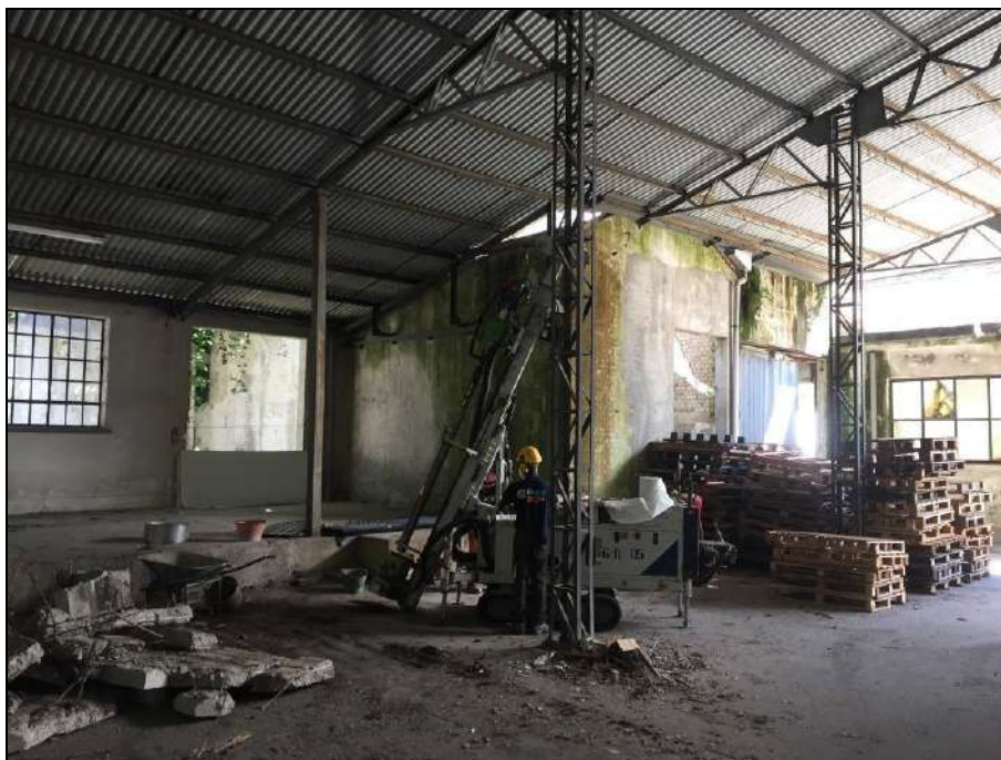
Foto n. 4.6 – Postazione sondaggio S4 profondo c.ca m 7,0 (m 6,6*) da p.c. (inclinato di 20° verso la vasca).
