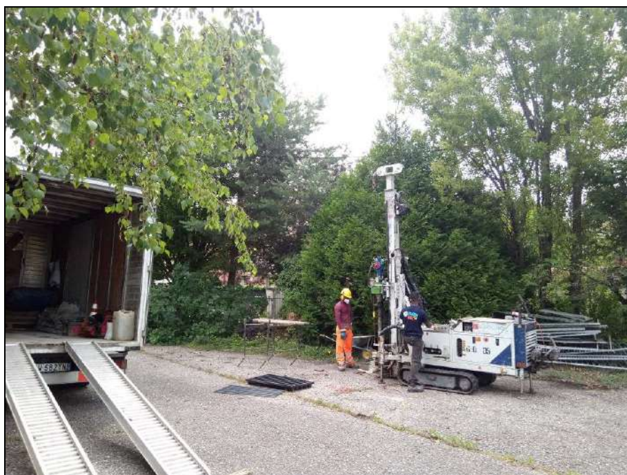
Foto n. 4.10 – Postazione sondaggio S8 profondo c.ca m 5,00 da p.c..
