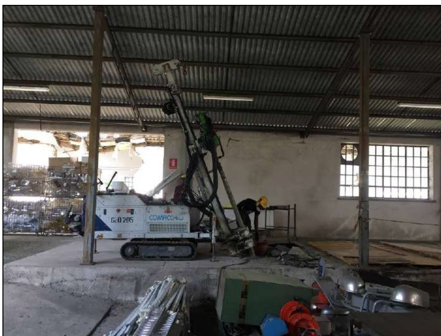
Foto n. 4.1 – Postazione sondaggio S1 profondo c.ca m 4,5 (m 4,3*) da piano tetto della vasca olio combustibile (inclinato di 20° verso la vasca).
