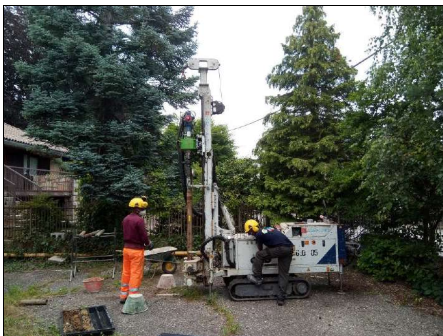
Foto n. 4.11 – Postazione sondaggio S9 profondo c.ca m 5,00 da p.c..
