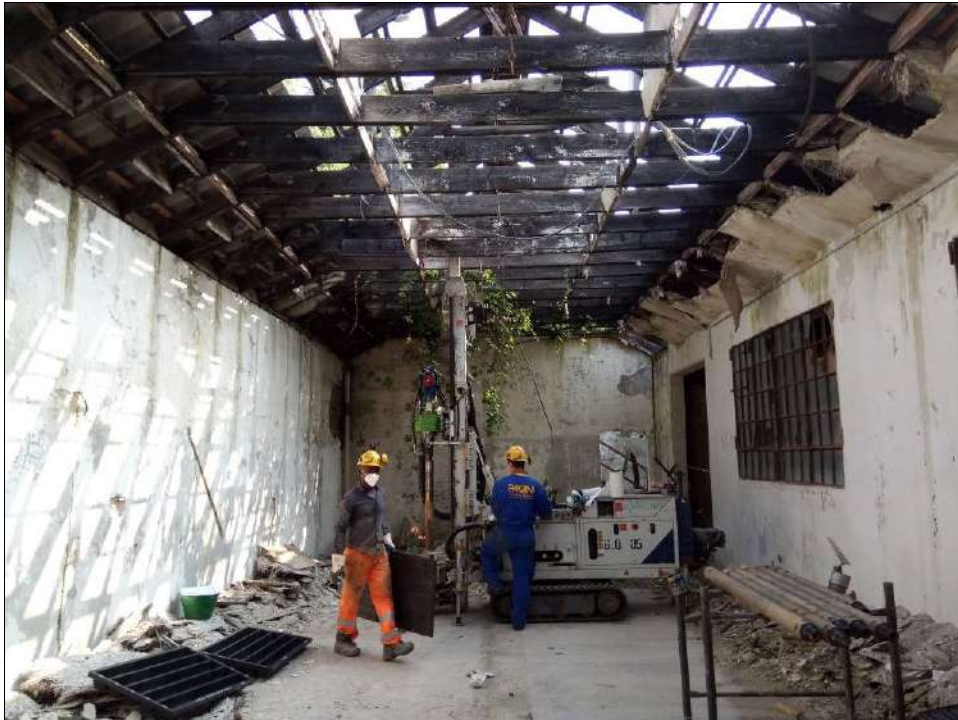
Foto n. 7.2 – Postazione sondaggio S15 profondo c.ca m 10,0 da piano tetto della vasca olio combustibile.
