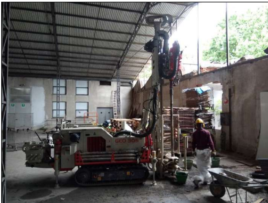
Foto n. 4.7 – Postazione sondaggio S5 profondo c.ca m 8,00 da p.c..
