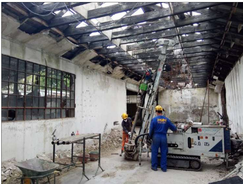
Foto n. 7.1 – Postazione sondaggio S14 profondo c.ca m 10,0 (m 9,4*) da piano tetto della vasca olio combustibile (inclinato di 20° verso la vasca).
