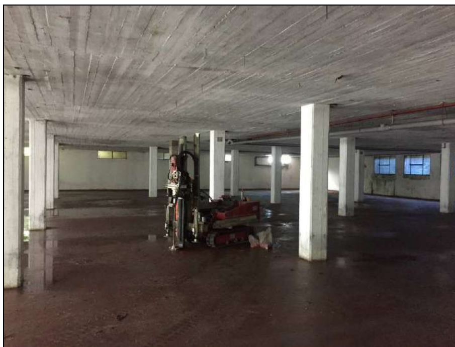
Foto n. 4.12 – Postazione sondaggio S10 profondo c.ca m 3,00 da p.c..
