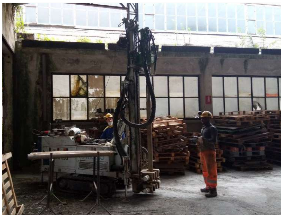
Foto n. 7.5 – Postazione sondaggio S18 profondo c.ca m 10,00 da p.c..
