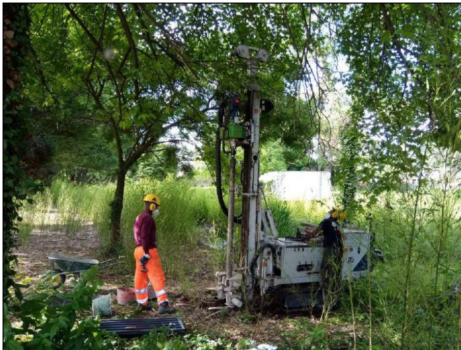
Foto n. 4.15 – Postazione sondaggio S13 profondo c.ca m 3,00 da p.c..
